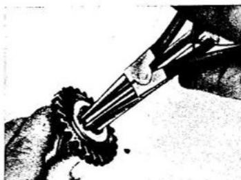
Abb. 37 Sicherungsring von der Tretlagerwelle abnehmen
